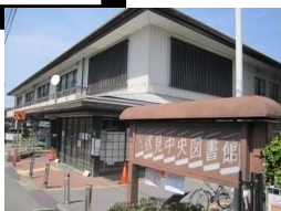
伏見中央図書館
