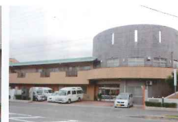
東高瀬川センター 平成11年開設
