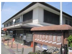
伏見中央図書館
